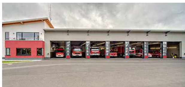
Das 2012 eröffnete neue Feuerwehrhaus in Staufenberg ist ein Muster für den Neubau in der Kernstadt. Der Zweckbau kostete 2,4 Mio. €.
